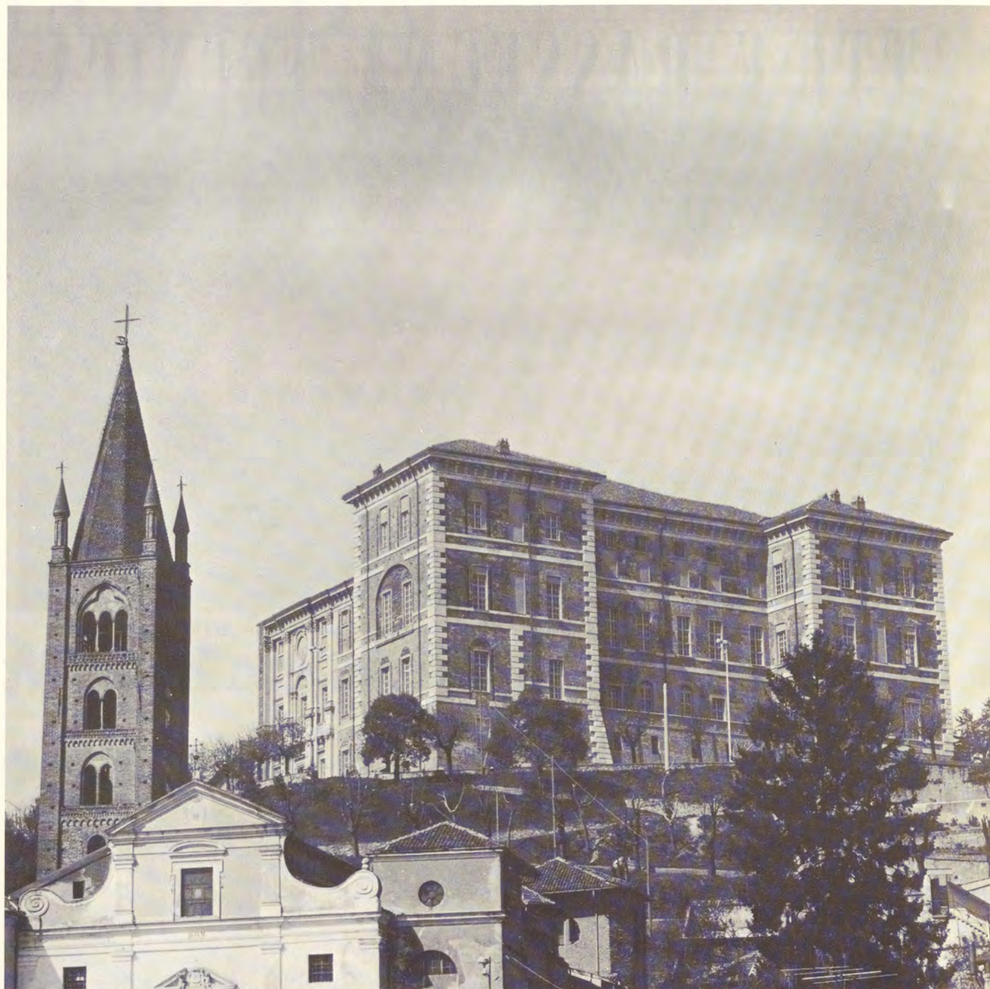
RESTAURO DEL CASTELLO DI RIVOLI
