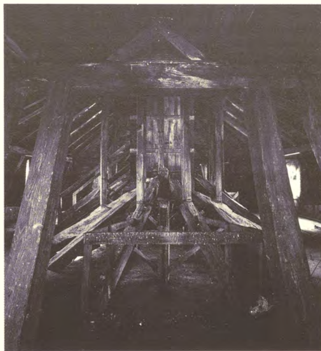
Fig. 4 - Stupinigi. Sottotetto salone centrale. Veduta longitudinale complessiva delle strutture lignee principali e secondarie.
