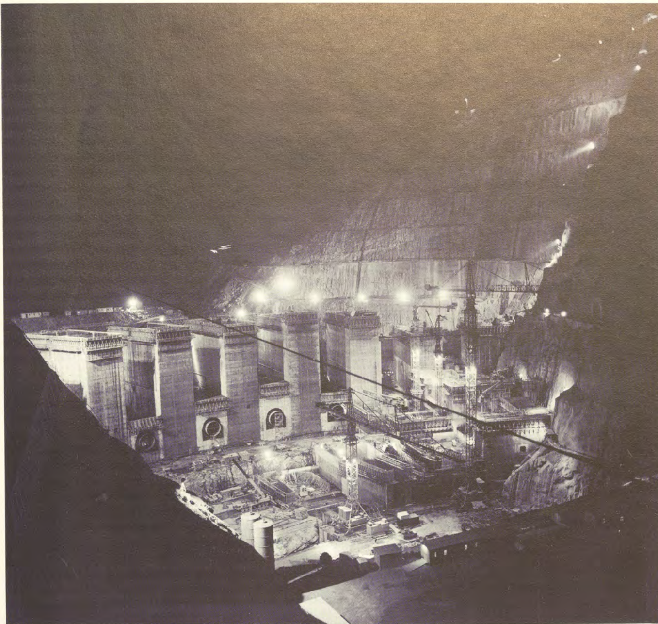
TURCHIA - DIGA DI KARAKAYA - ITALSTRADE RECCHI
