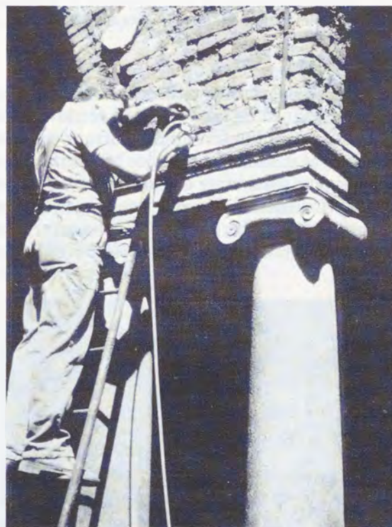
Fig. 8 - Chiesa di S. Eustorgio. Misura dello stato di sollecitazione su un pulvino.
