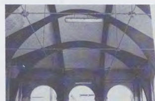
Fig. 12 - Il sistema di copertura laterizia del Mercato di Vinovo, opera di Caselli.
