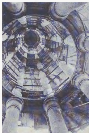
Fig. 5 - La guglia della Mole prima del crollo; gli snelli pilastri circolari sostengono le aeree scale ad elica.
