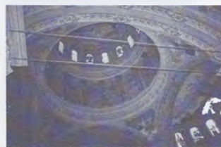
Fig. 11 - Il tamburo e la cupola della Chiesa di Camagna progettata da Caselli; in primo piano i tiranti metallici che collegano le imposte degli arconi.
