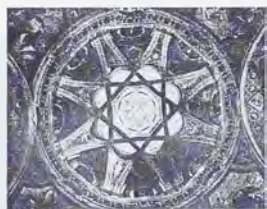
Fig. 3-4 - Lo scheletro del volto della Mole Antonelliana realizzato con un sistema di archi incrociati che richiama quelli adottati dal Guarini nella Chiesa di San Lorenzo in Torino.
