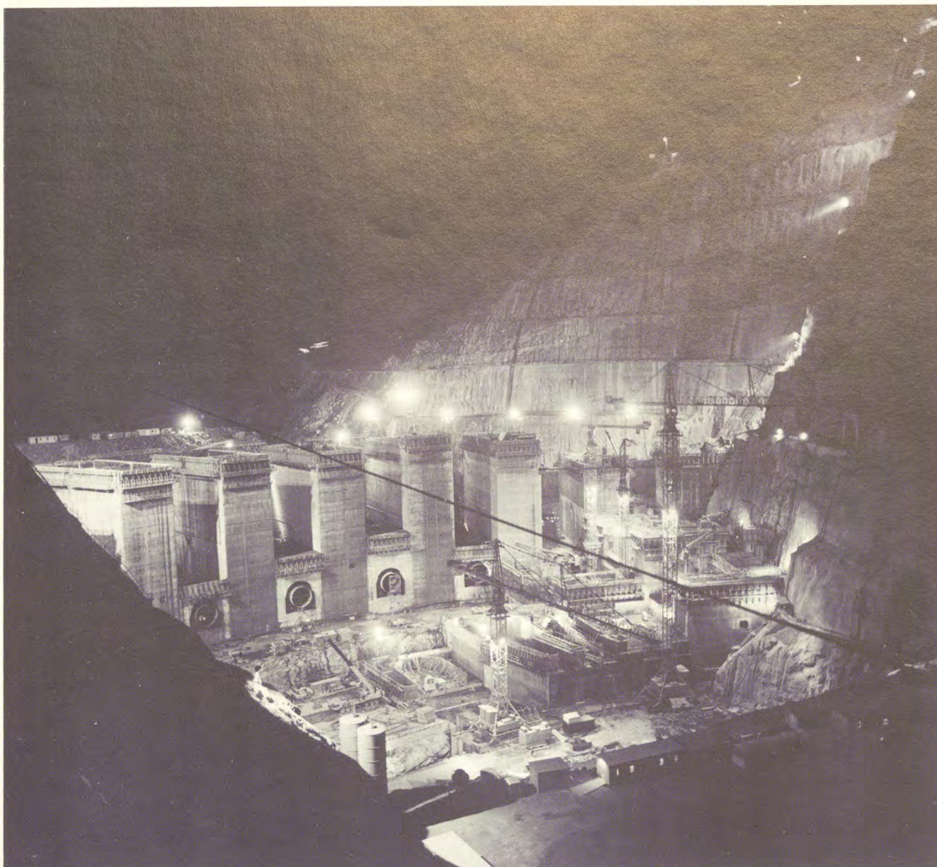
TURCHIA - DIGA DI KARAKAYA - ITALSTRADE RECCHI
