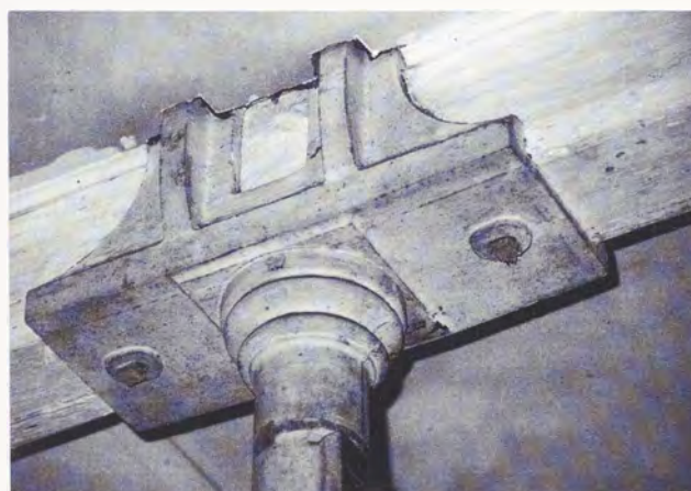
Fig. 5 - Manifattura di Cuornè (primo nucleo, 1872): particolare dell'attacco delle travi maestre trasversali di legno alla scatola di ghisa sporgente dal fusto della colonna, fusa assieme al capitello.
