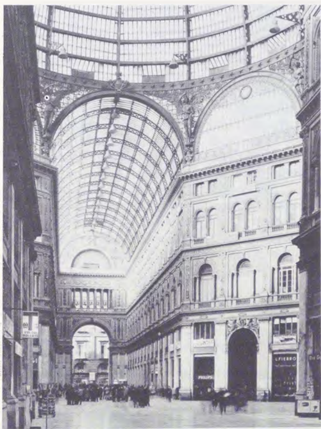
Fig. 15 - La cupola della galleria Umberto I a Napoli (1885).
