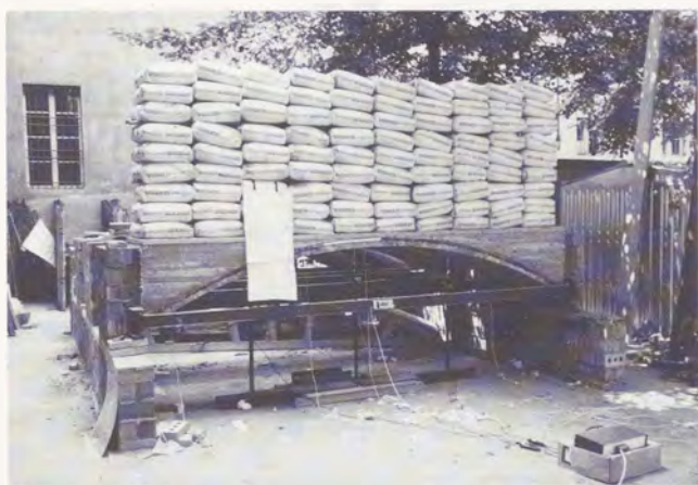
Fig. 5 - La volta consolidata con calotta di vetroresina ha denunciato un comportamento perfettamente elastico sotto un sovraccarico ripartito equivalente a circa 1300 kg/m 2 .
