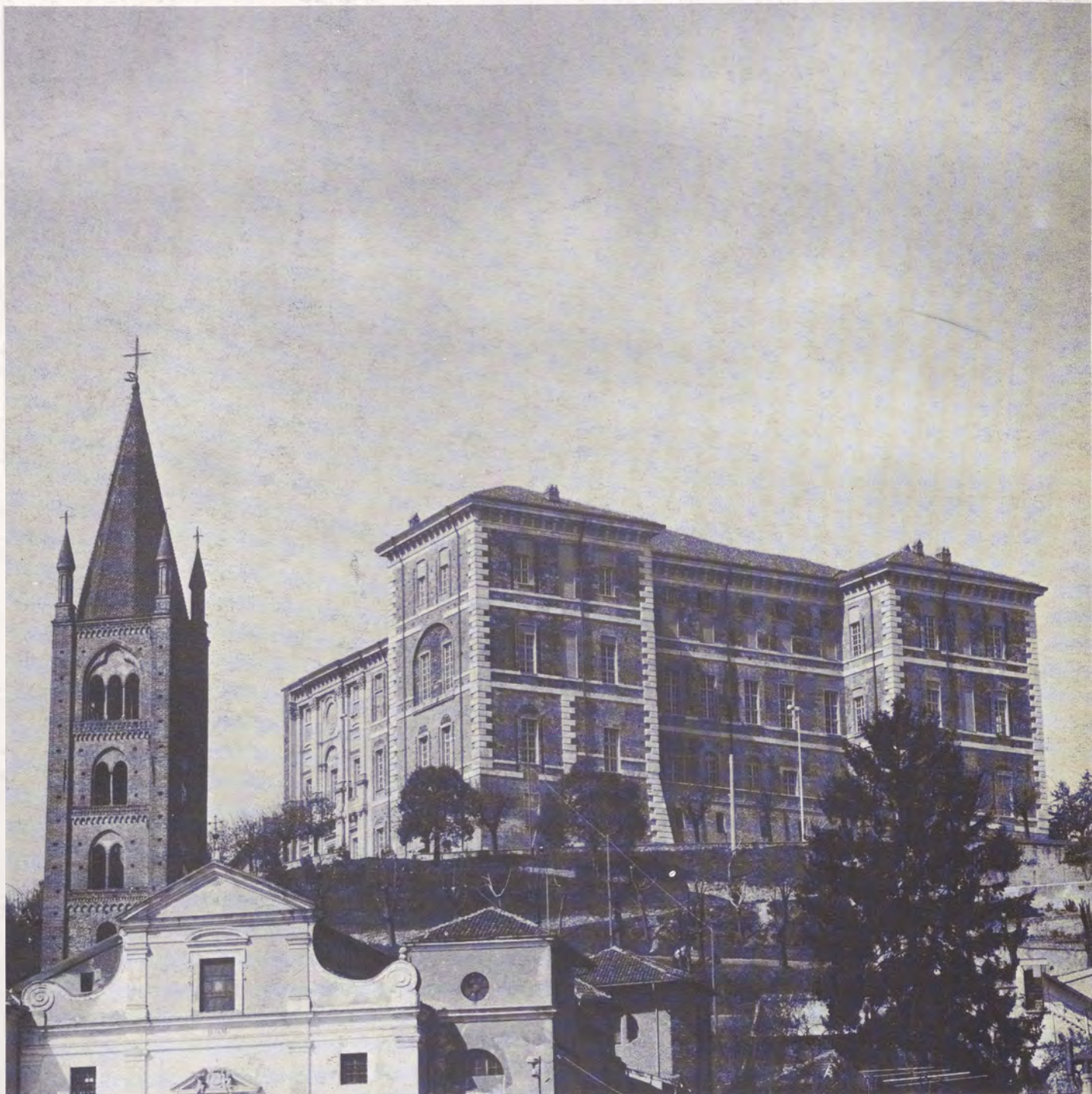
RESTAURO DEL CASTELLO DI RIVOLI
