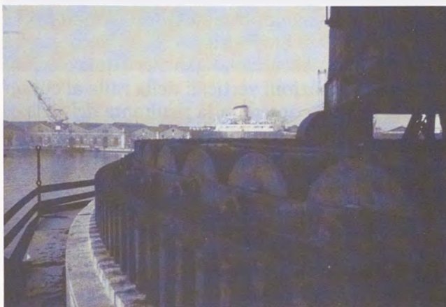
Fig. 11 - Gru idraulica dell'Arsenale di Venezia: particolare della piattaforma girevole con rulli di ghisa.
