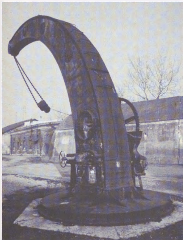
Fig. 9 - Gru a «collo d'oca» dell'Arsenale di Venezia: modello Fairbairn da 35t, installata nel 1874.
