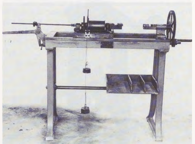
Fig. 12 - Macchina per prove di torsione su fili.
