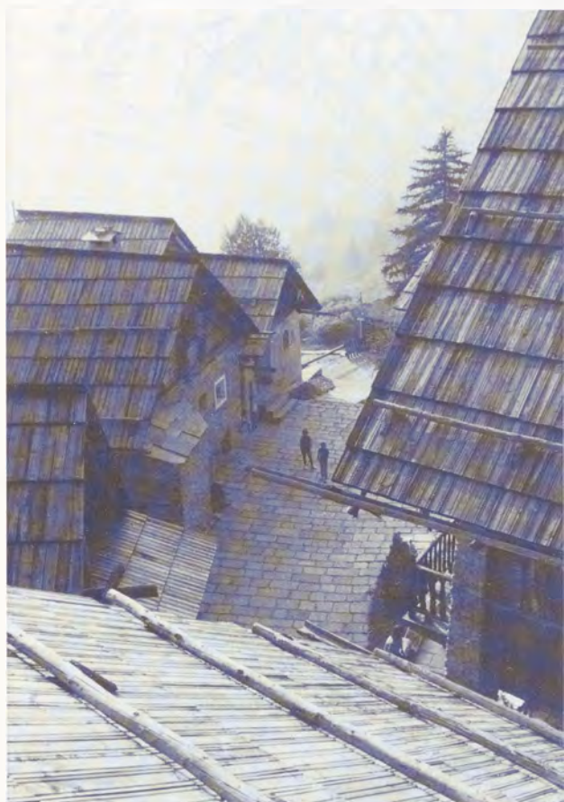
Fig. 2 - I tetti sulla piazzetta centrale del complesso dopo l'intervento.
