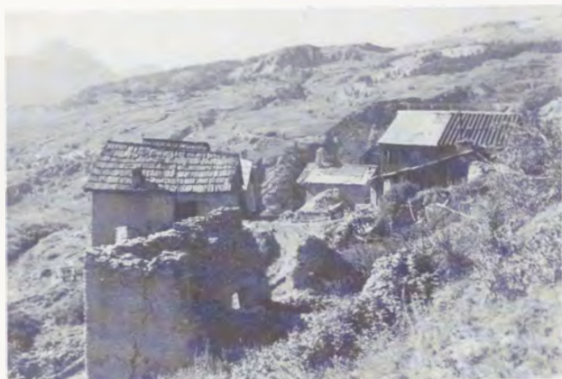
Fig. 1 - Il complesso di Grangesises prima dell'intervento.
