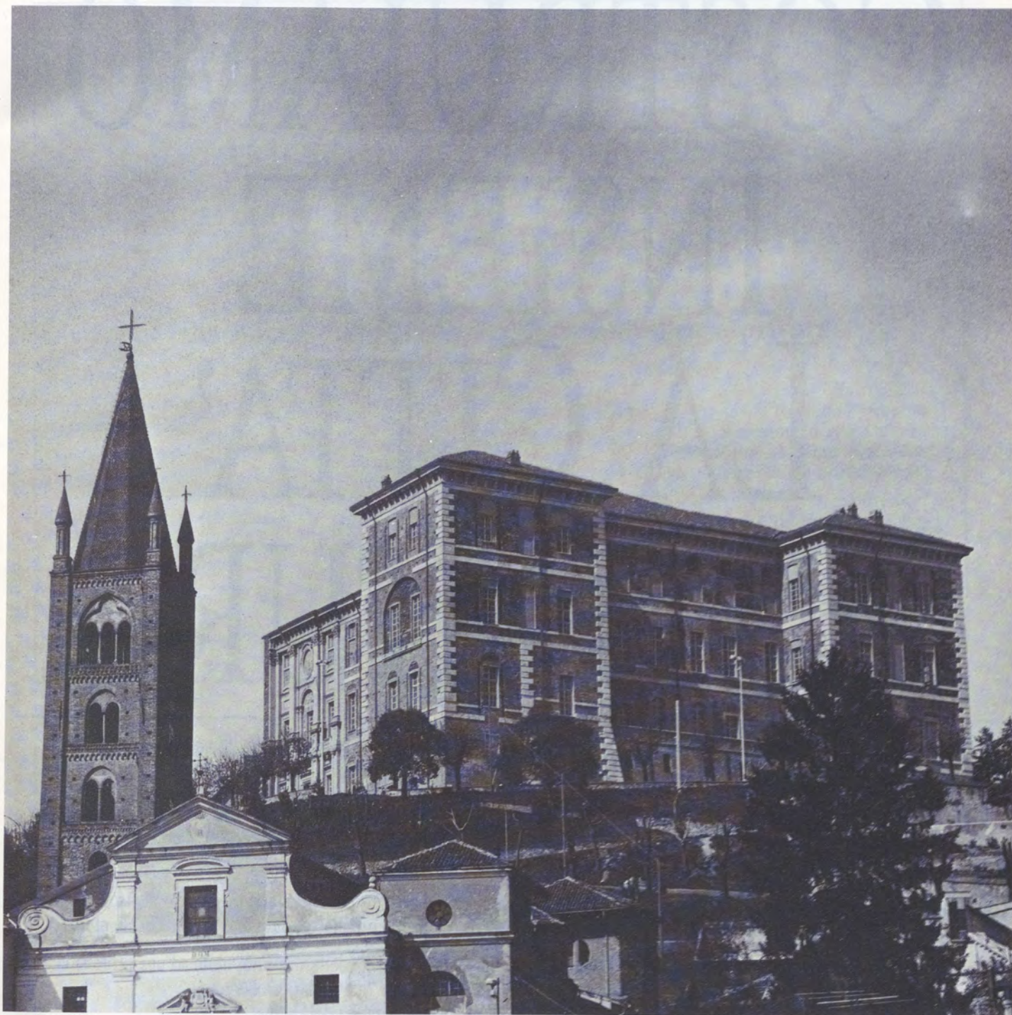
RESTAURO DEL CASTELLO DI RIVOLI
