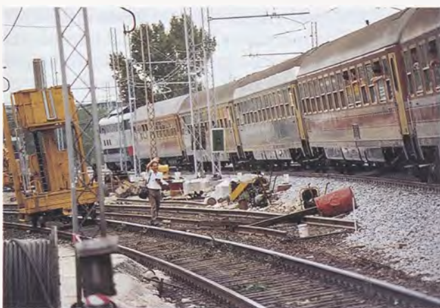
Fig. 26 - Fase n. 3 di attivazione del quadruplicamento in zona Stura. Si possono notare i vecchi binari dismessi ed i nuovi appena attivati a quote diverse: tutte le operazioni di attivazione sono state eseguite in 5 ore.
