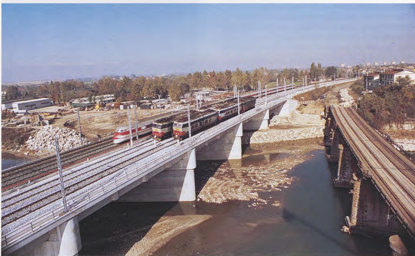
Fig. 22 - Ponte Stura - Vista dell'opera durante il collaudo statico. Si possono notare il ponte dismesso e parte delle protezioni spondali.
