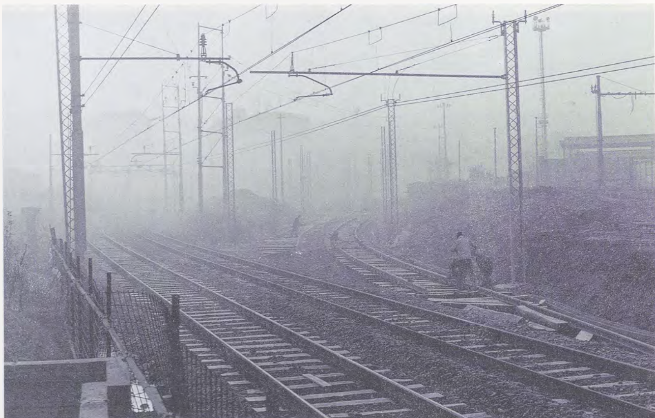
Fig. 25 - Deviazione provvisoria della linea Lingotto-Modane, zona Corso Bramante. Sono evidenti le interferenze con gli impianti esistenti.
