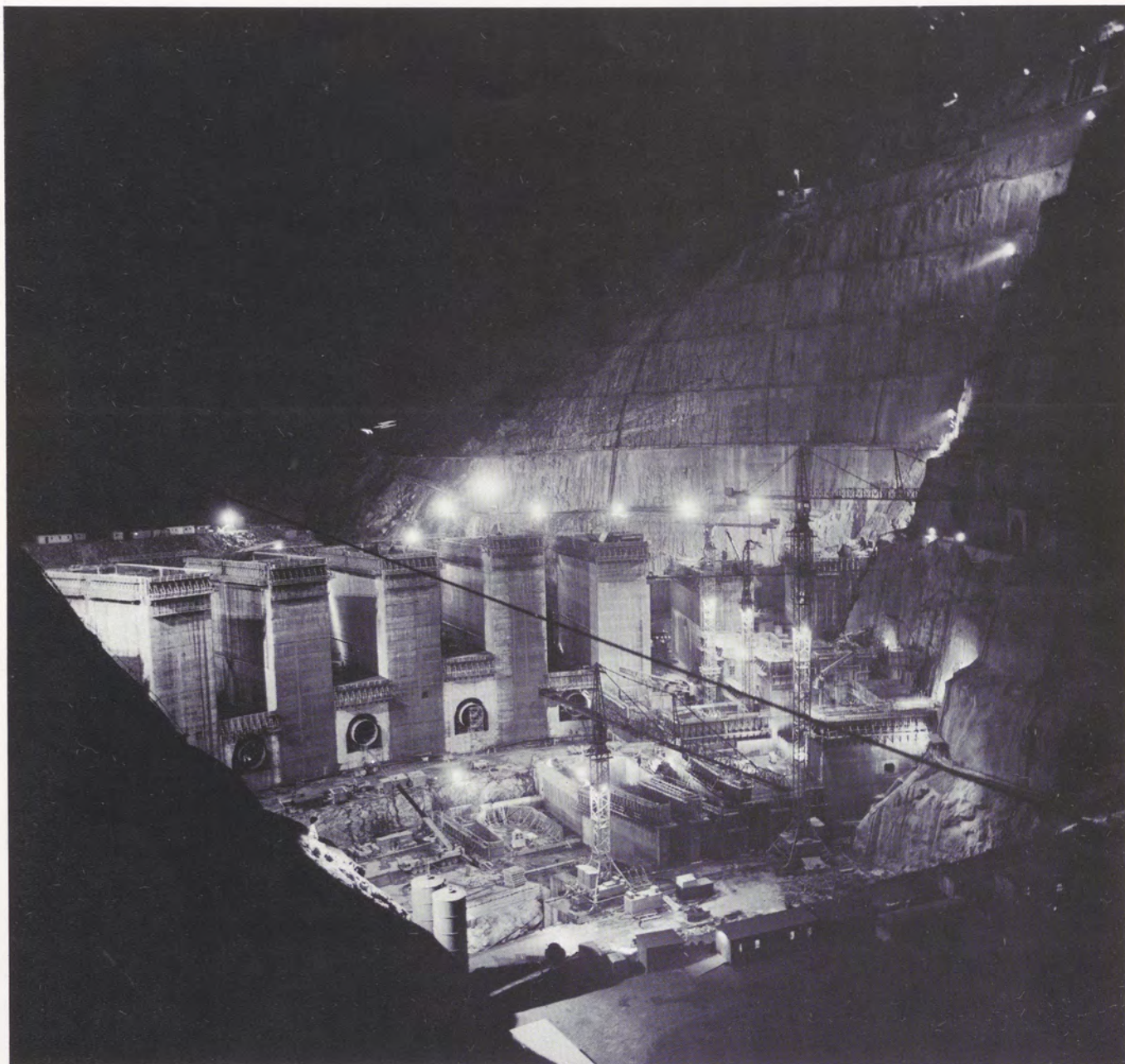
TURCHIA - DIGA DI KARAKAYA - ITALSTRADE RECCHI
