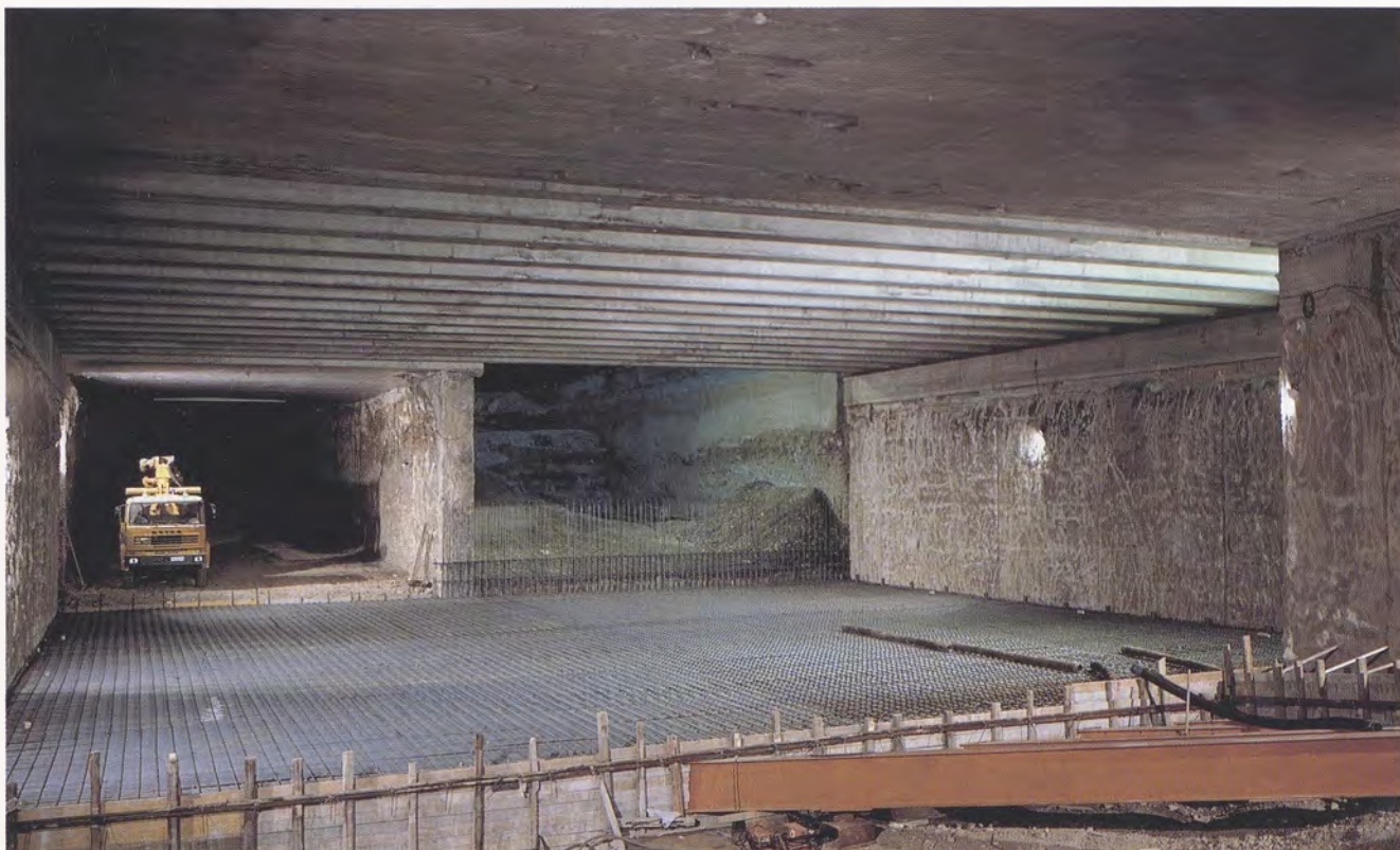
Fig. 21 - Vano superiore del camerone di confluenza delle linee passante e veloce Porta Nuova-Porta Susa, zona Corso Re Umberto. Riferimento alla sezione E della tavola fuori testo n. 1.
