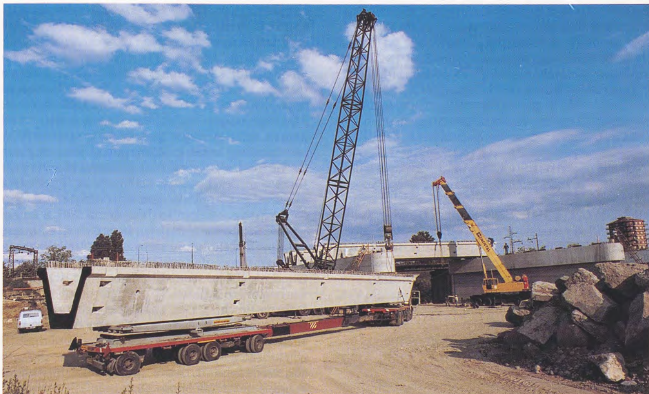
Fig. 23 - Ponte Stura. Varo delle travi.
