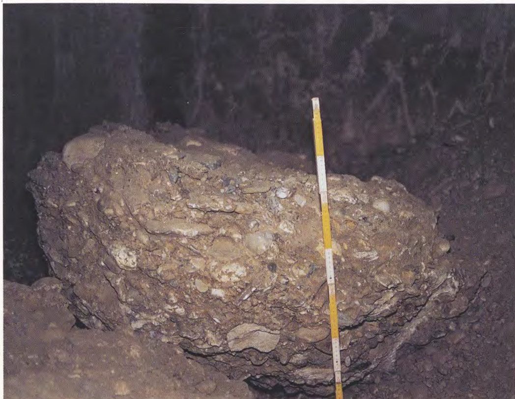
Fig. 17 - Aspetto tipico del conglomerato presente nella formazione da scavare. Sono evidenti le concrezioni di calcite attorno ai ciottoli in parte cementati e in parte avvolti come in uno stampo.
