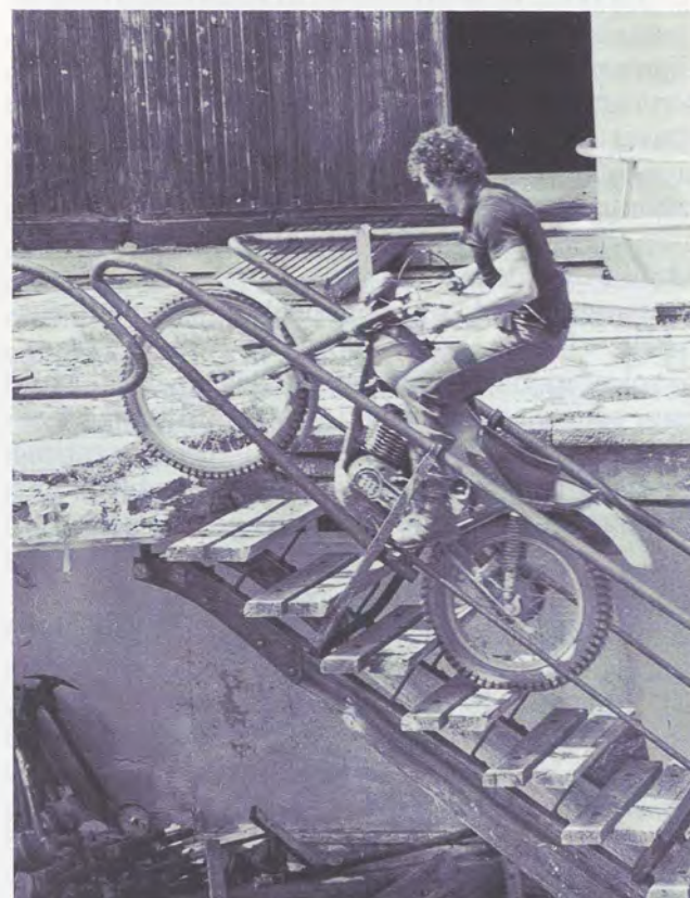
Fig. 4 - Stato di degrado della stazione nel 1979, usata come pista di motocross (Foto P. Diamante).
