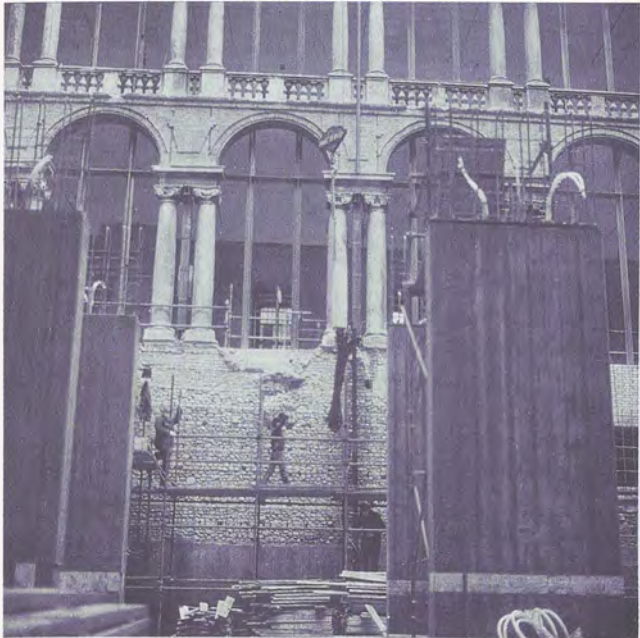
Sottomurazione per la realizzazione del salone interrato.
