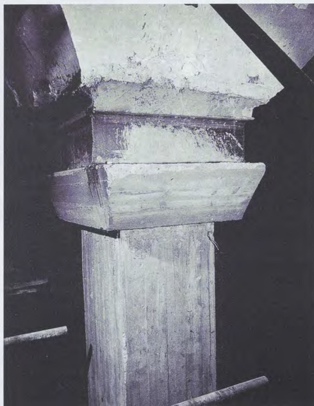
Pilastro di sostegno alle volte nell'interrato.
