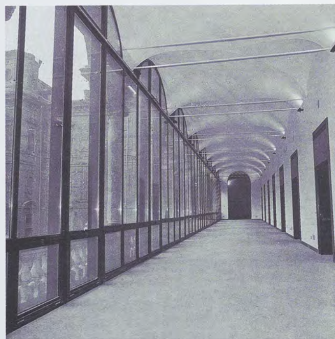
La galleria vetrata al primo piano.
