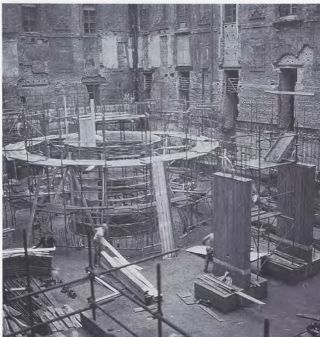
Nuova scala di sicurezza circolare del salone interrato e particolare della struttura.
