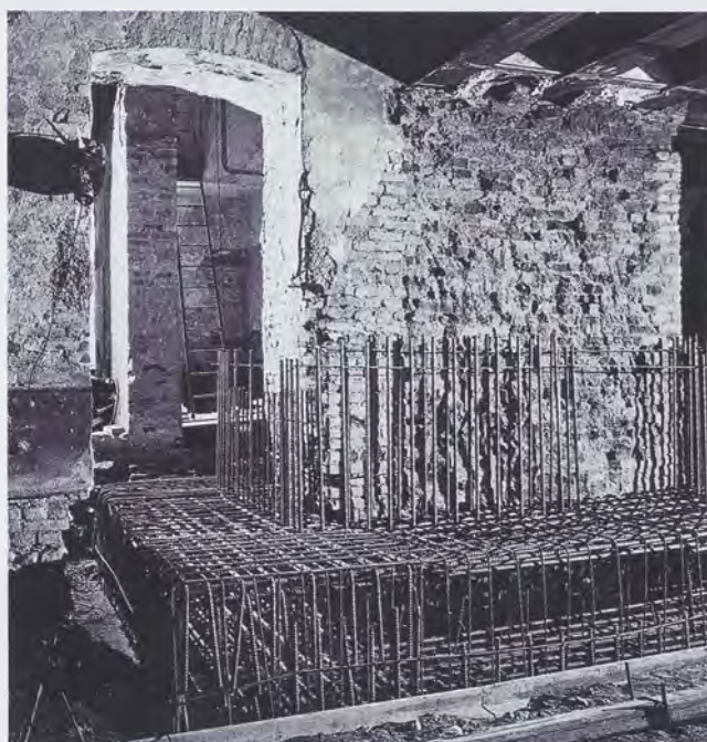
Uno dei plinti di base a sostegno del fulcro centrale della crociera.
