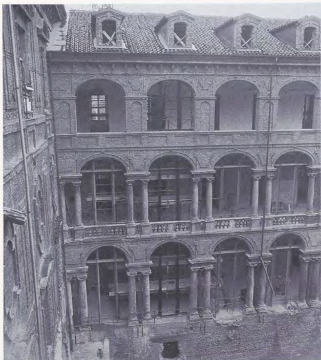
Il loggiato interno durante i lavori.
