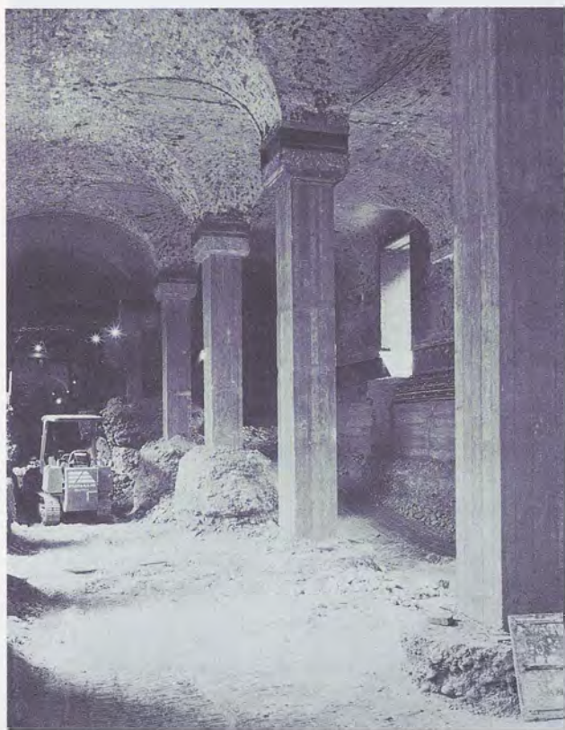
I nuovi pilastri all'interrato.
