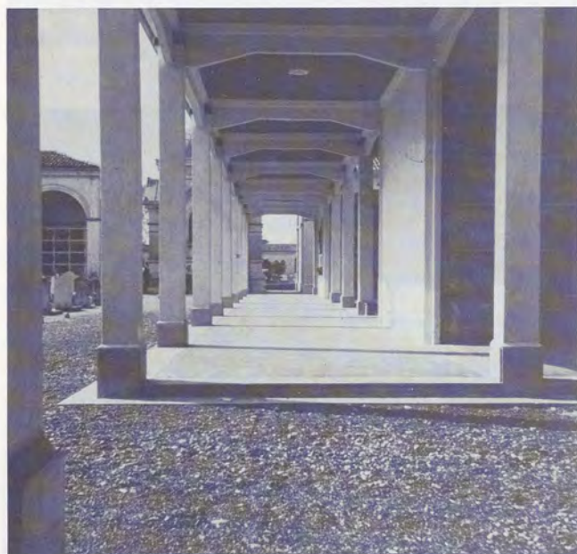
Vista sul portico del 1° ampliamento.
