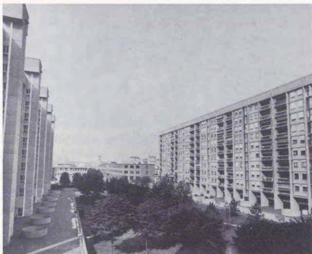
Consorzio edilizio Bologna. Vista dallo spazio interno fra i corpi di fabbrica.
