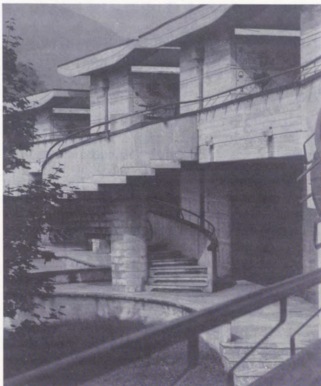
Cimitero di Cuorné. Vista delle rampe di accesso al livello superiore.
