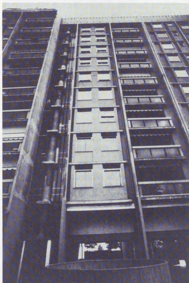
Consorzio edilizio Bologna. Vista dallo spazio interno fra i corpi di fabbrica.
