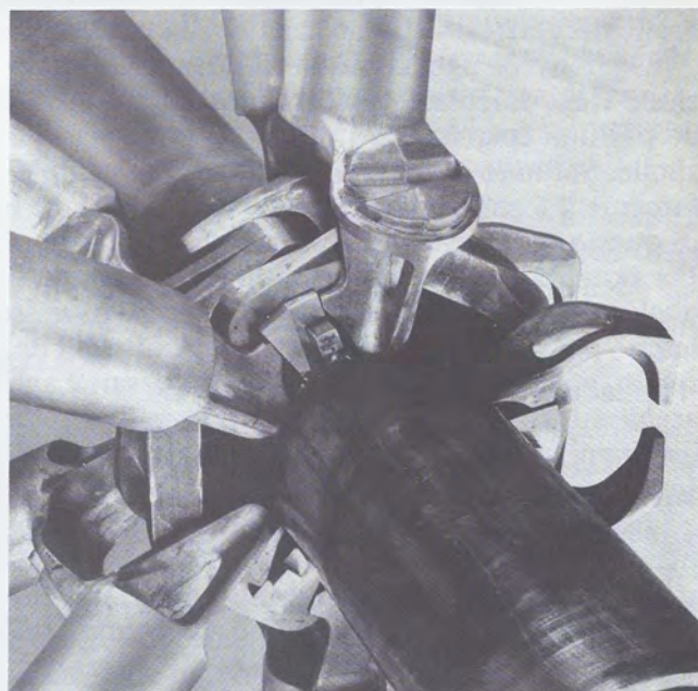
Fig. 10 - Giunto studiato da Wachsmann nel 1951 su incarico dell'Aviazione americana, per la realizzazione di vaste tettoie con elementi standard (da Wendepunkt in Bauen , op. cit.).
