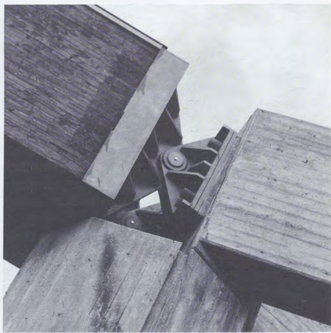
Fig. 56 - Cerniera di appoggio in acciaio inox.
