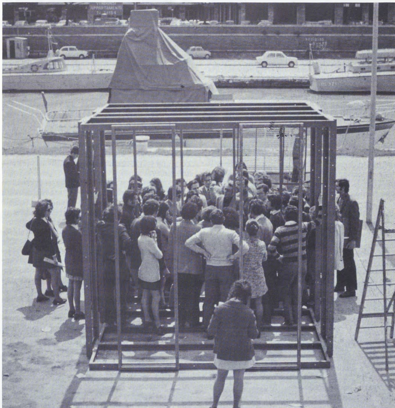
Fig. 5 - Unità cubica (3x3x3ml) assemblata dagli studenti del Corso di Morfologia delle Strutture architettoniche dell'Università G. D'Annunzio di Chieti sul porto canale di Pescara nell'Anno Accademico 1969/70 (foto di Giovanni Guazzo).
