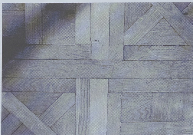
Fig. 6 - Castello del Valentino, Sala Verde. A sinistra il pavimento nella soluzione d'angolo rappresenta la classica disposizione Versailles , caratterizzata da una cornice assemblata con tenoni e mortase, dove il riempimento è costituito da liste, poste obliquamente secondo la direzione della diagonale, interrotte per far passare alternativamente le liste fra loro perpendicolari. A destra, particolare di due riquadri a soluzione Versailles e a disposizione Chantilly , con riempimento a liste ortogonali alle cornici (foto A. Godio, 1998).
