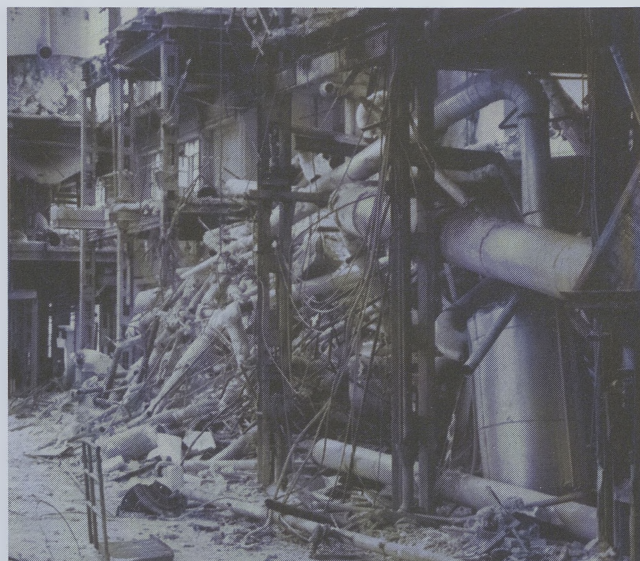
Fig. 5 - Demolizioni industriali non effettuate in conformità alla legislazione sull'amianto.
