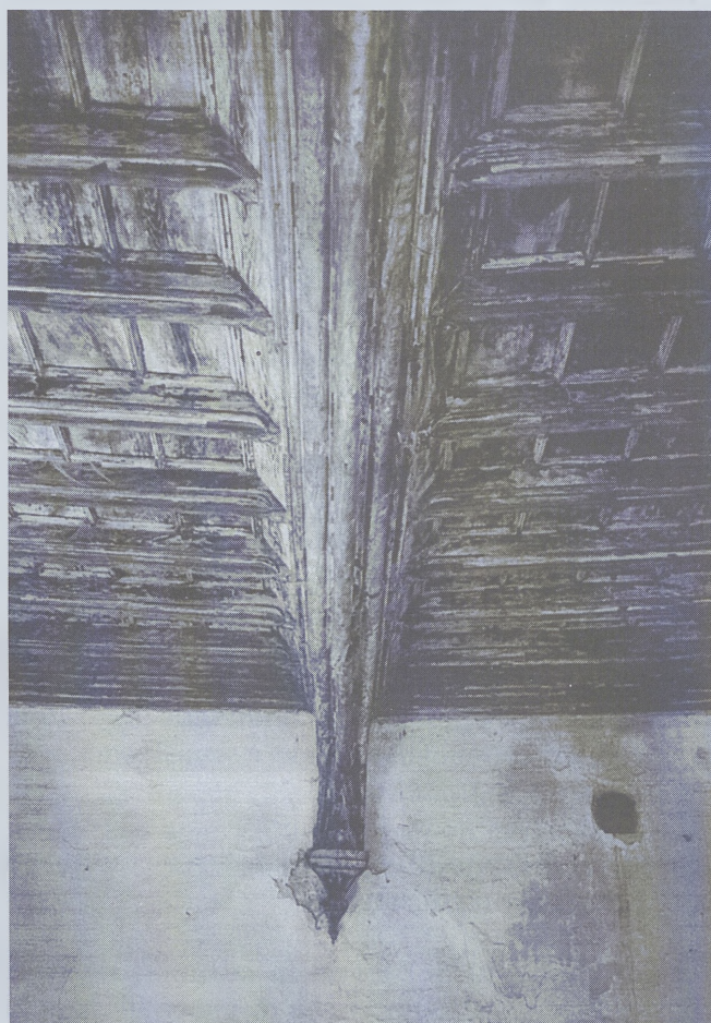
Fig. 3 - Castello di Casalgrasso (CN). Cassettonato Seicentesco di Quercia: la trave principale bisellata che poggia su una mensola rappresenta una raffinata tipologia dei solai lignei piemontesi (foto C. Bertolini Cestari, 1997).
