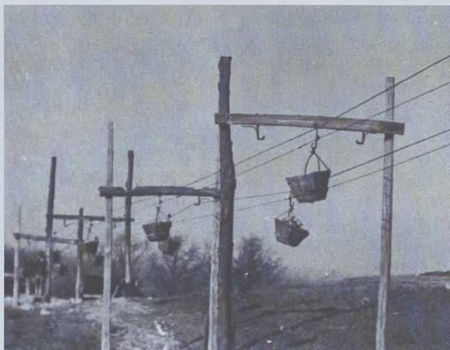
Fig. 5 - Trasporto della marna mediante teleferica.
