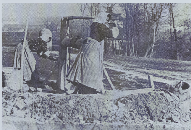
Fig. 4 - Donne impiegate alla estrazione della marna da un pozzo mediante verricello.
