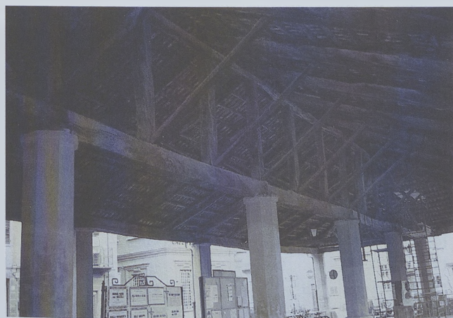
Fig. 4 - Villafranca Piemonte (TO). La singolare copertura dell'ala del mercato con la grossa orditura che copre una luce considerevole (foto C. Bertolini Cestari, 1997).
