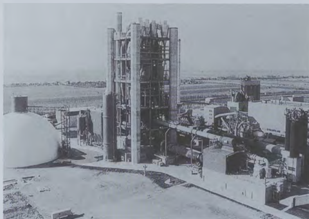
Fig. 7 - Forno rotativo con preriscaldatore a cicloni (3500 ton/giorno).
