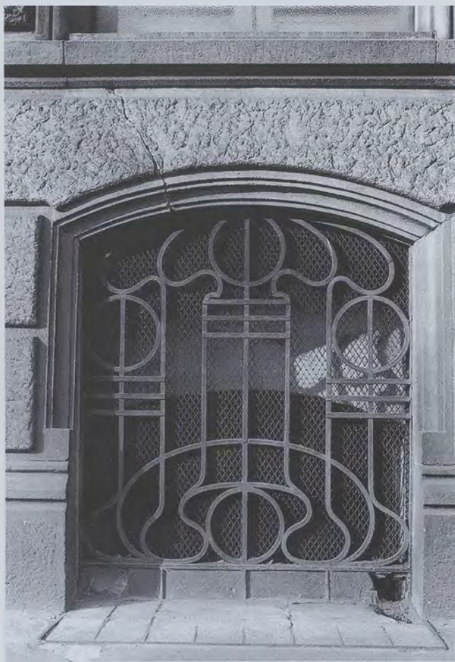
Fig. 8 - Esempio di ferro battuto realizzato con tecniche semplificate (giunzioni a mezzo spessore, chiodature, ecc.) comunque dimostrante una ricerca di eleganza complessiva (casa Rey, Torino, 1904, ing. P. Fenoglio).
