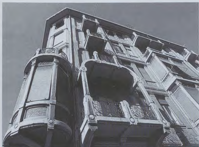
Fig. 3 - Scorcio della facciata di casa Marangoni, Torino 1904, con parti in calcestruzzo armato a vista ed elementi in pietra artificiale.
