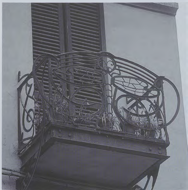
Fig. 9 - Esempio di impiego di semplici profilati di serie, lavorati con fantasia, per realizzare ringhiere caratterizzanti fortemente l'edificio, anche se di impianto modesto (casa Colongo, Torino 1904, ing. A. Vandone di Cortemiglia).
