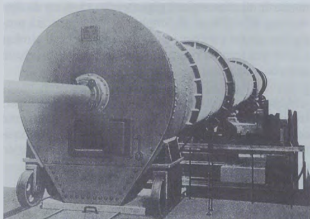
Fig. 7 - Forno rotativo con preriscaldatore a cicloni (3500 ton/giorno).
