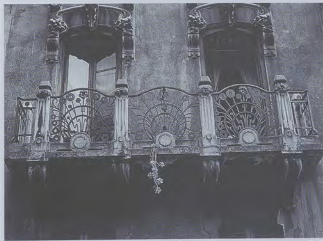
Fig. 4 - Esempio di elementi di balcone in pietra artificiale e ferri battuti (casa in via Piffetti 3, Torino, ing. G. Gribodo).
