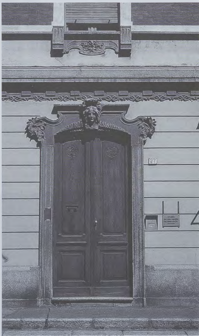
Fig. 5 - Esempio di impiego di elementi in pietra artificiale in area provinciale per portoncino e cornice di casa d'abitazione (Pinerolo, via Saluzzo 27).
