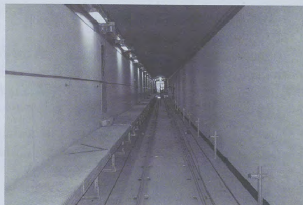
Via di corsa: tratto orizzontale in preparazione.
