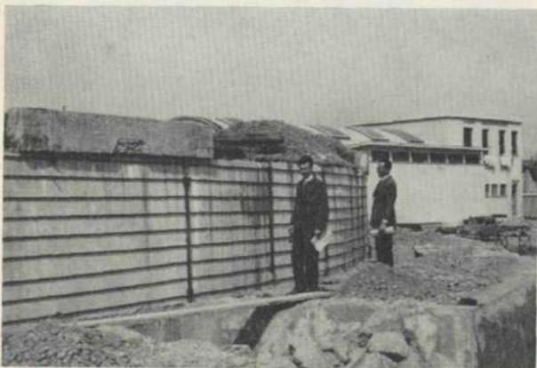
prima fase dell'operazione; in essa si vedono già disposti tre profilati distanziatori. Su analogo automezzo (fig. 19) è stata montata una gru girevole per la manovra della pressa di messa in tensione della fune. In tutta l'operazione di pretensione sono stati utilizzati complessivamente nove profilati distanziatori, divisi in tre gruppi di tre, disposti inizialmente a distanza angolare reciproca di 120°.
