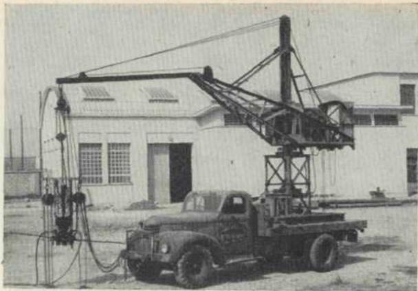
Fig. 19. - Attrezzatura mobile per la precompressione dei serbatoi.
