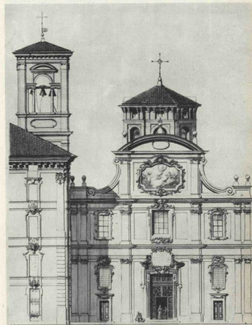
Fig. 19. - Facciata della Chiesa di S. Damazzo (V. Garibaldi ang. V. delle Orfane) edificata su altra preesistente nel 1530, decorata verso il 1565, riparata e rifatta nel 1702. Il Campanile venne sopraelevato nel 1710, la Cupola venne costruita nel 1896.
