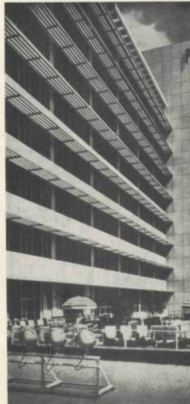
Fig. 3 - Parete con frangisole fissi a pensilina nel Prudential Building in Los Angeles (California) nella quale l'ombra rinfresca tutto il muro.
