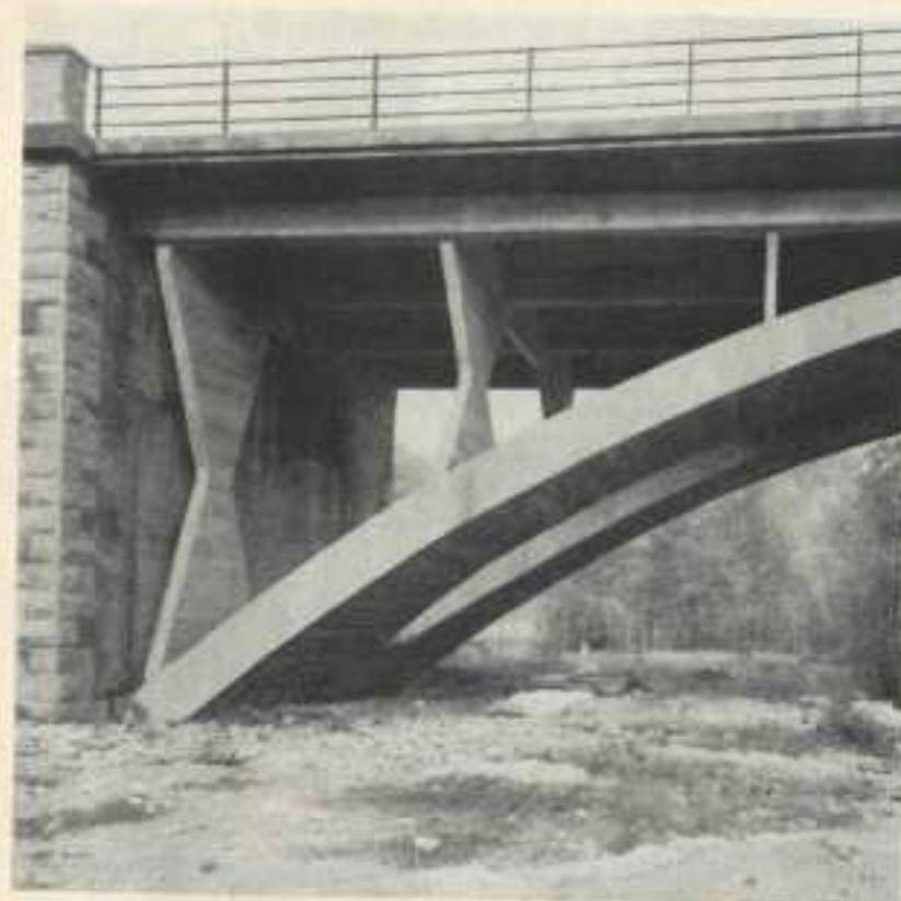
Fig. 11 - Particolare dei diaframmi e vista inferiore dell'impalcato.
