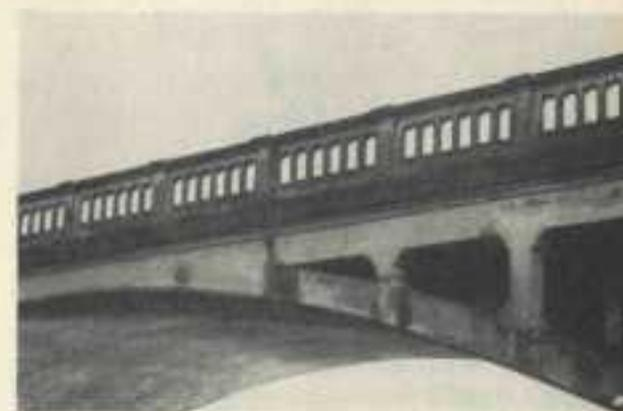
Fig. 13 - Particolare di piedritti lesionati in un vecchio ponte in c. a. (vista da valle e vista da monte).
